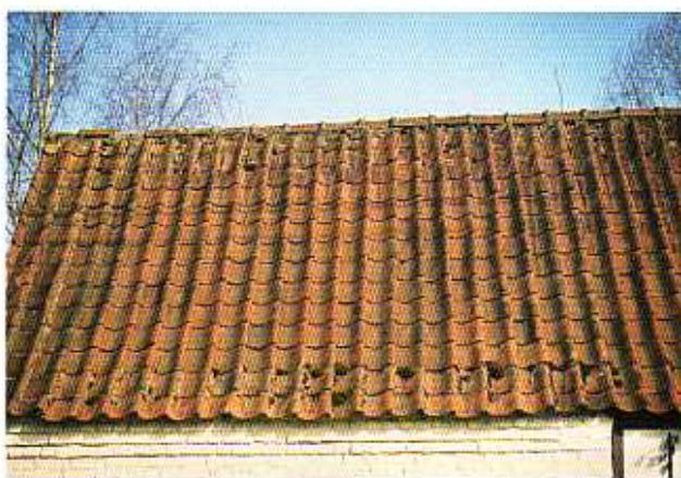
une toiture couverte par de vieilles tuiles
