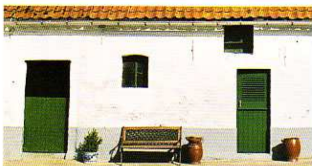
de format et de localisation diverses, les ouvertures percées sur les murs ont chacune une utilité bien précise
