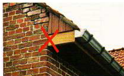
un débordement de toit inutile qui induit des détails de finition dommageables pour la compacité du pignon
