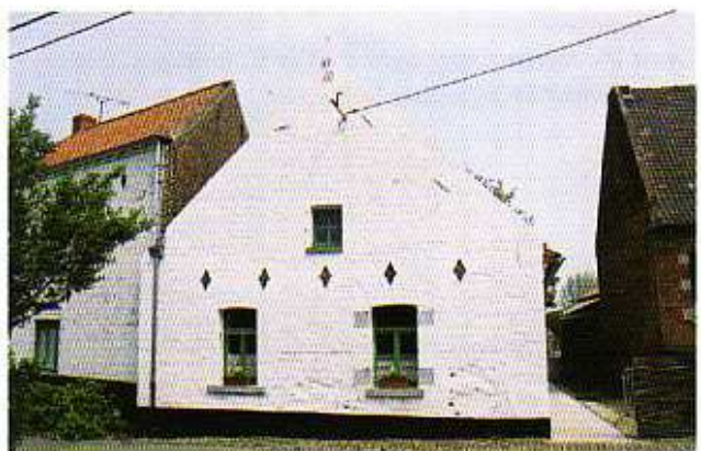
un mur de brique badigeonné de blanc, avec un soubassement distinct
