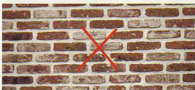
... et non des briques rustiques « panachées » qui simulent un mélange de briques de récupération blanchies à la chaux
