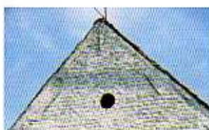
ouverture de ventilation de l'étage
