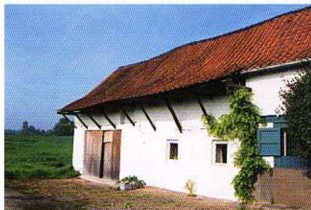
un large débordant de toiture protège parfois les accès aux dépendances agricoles
