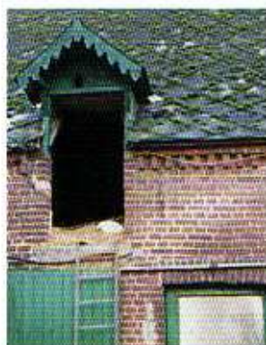
des exemples de lucarnes passantes : lucarne rampante (à gauche) et lucarne à deux versants (à droite)
