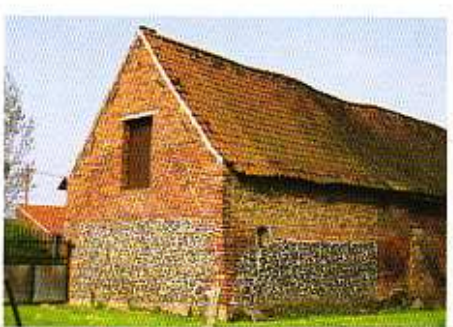
Au Pays des Collines, l'utilisation de la pierre calcaire pour les murs est exceptionnelle
