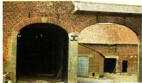
renforçant la cohésion murs/charpentes, l'ancre est inscrite sur le parement des murs. Elle date le bâtiment ou désigne son propriétaire.
