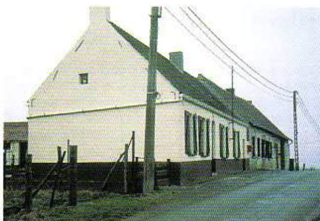
un pignon étroit sans ouvertures
