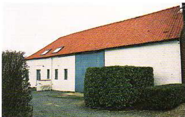
un ensemble de baies verticales, aux dimensions réduites qui s'intègrent dans la façade de la grange
