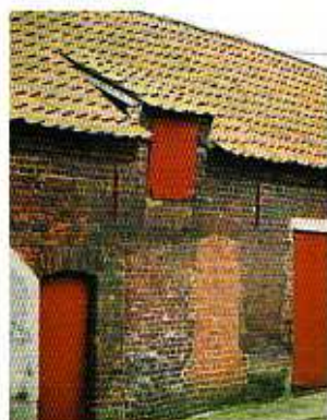
des exemples de lucarnes passantes : lucarne rampante (à gauche) et lucarne à deux versants (à droite)
