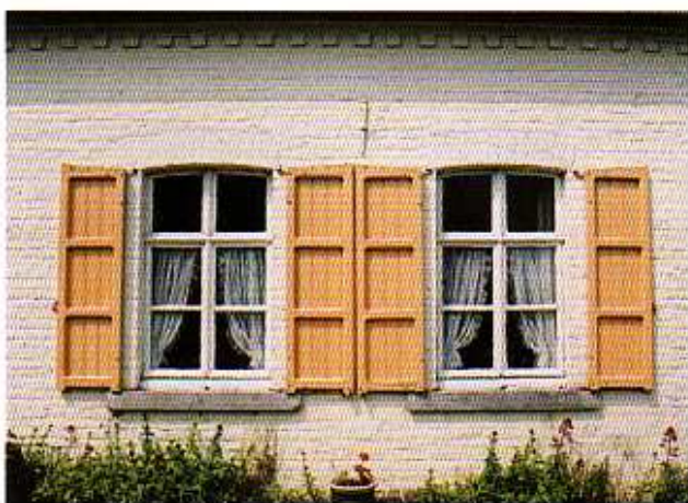
une autre solution pour garder une façade lumineuse : la remise en peinture de volets existants, comme ici sur d'anciennes baies de fenêtres
