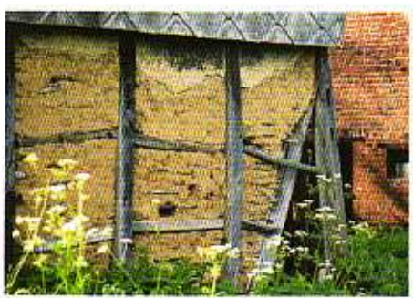
un détail de paroi en torchis composée de l'ossature en bois, du clayonnage et du remplissage à base de terre
