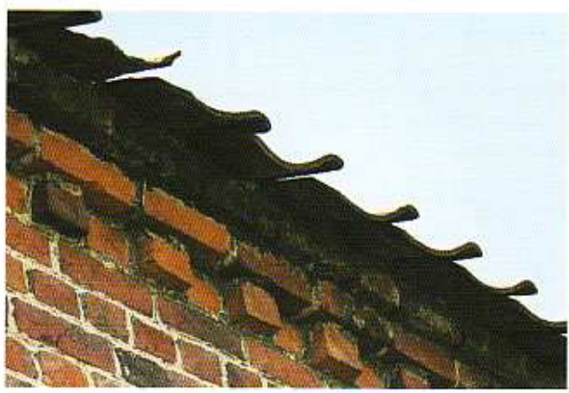
une frise saillante sur le haut du mur
