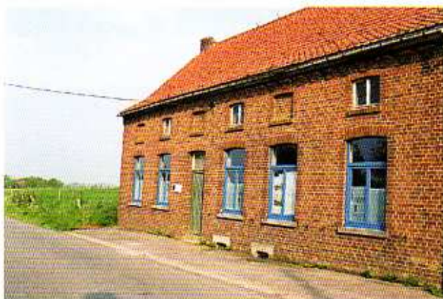
un remplacement de châssis réussi !
