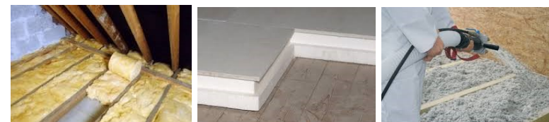
Isolation entre gîte
