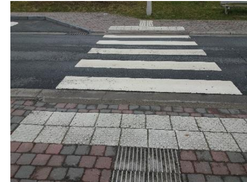
Abaissement et dalles podotactiles
