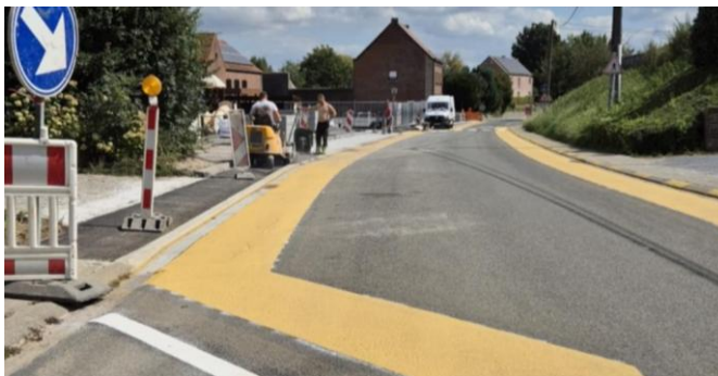
Aménagements cyclables école de Wodecq Source : Ellezelles.be
